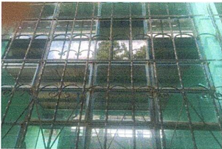
3.1 sustitución de vidrios transparente de 5mm de grosor
