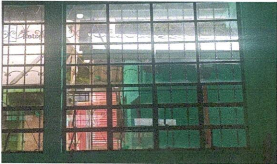
3.2 mantenimiento a balcones de metal lijado y aplicación de pintura
