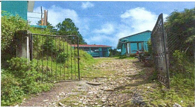
2.2 mantenimiento de portón de metal con las medidas de 250 x 350
