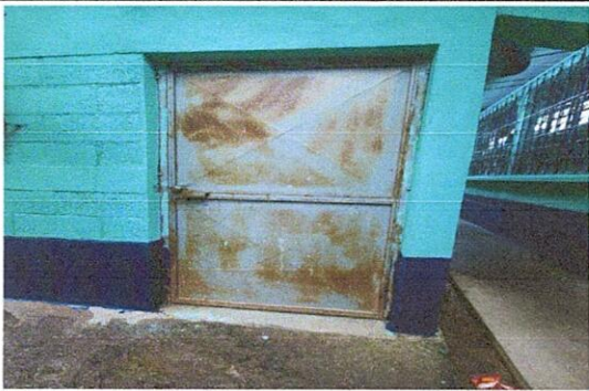
Foto 2.1 mantenimiento de estructura (lijado y aplicación de pintura en puertas metal
