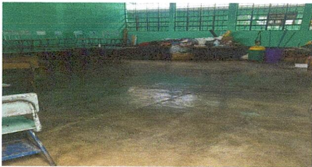
Foto 4: 1 sustitucion de piso de concreto por cerámica
