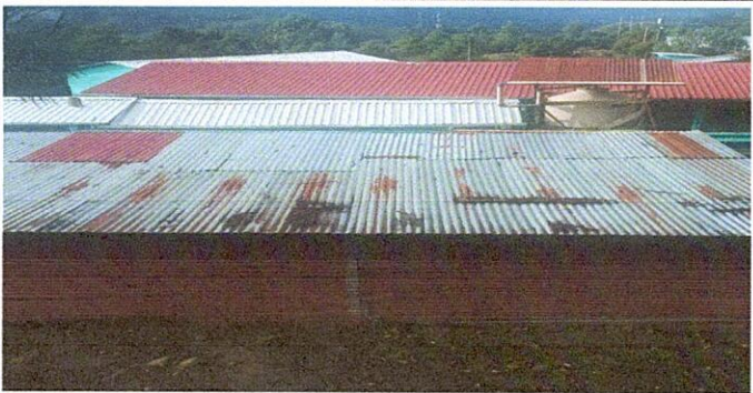
Foto 1. 1: matenimiento y aplicación de pintura en estructura de soporte de metal y techo de lamina troquelada.
