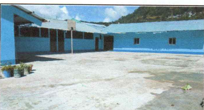
Foto 6: PINTURA EN MUROS EXTERIORES E INTERIORES
