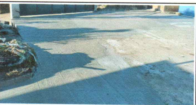
Foto 5: LOSA DE PATIO, colocacion de torta de cemento
