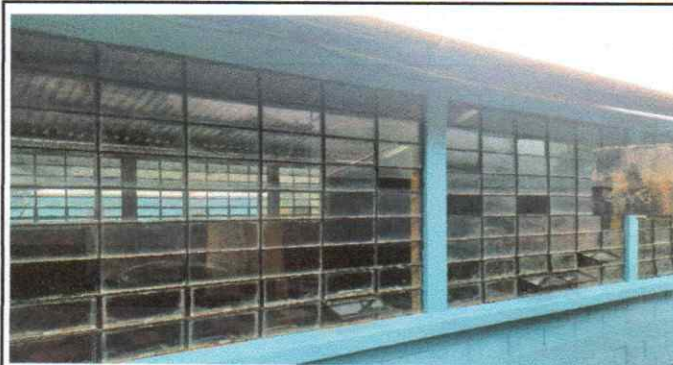
Foto 1: VENTANAS, sustitucion de vidrios
