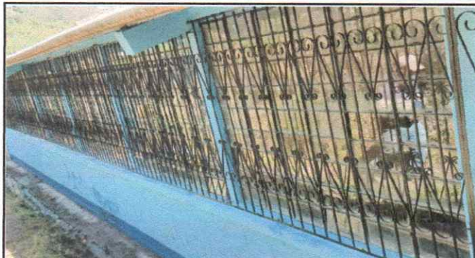
Foto 2: VENTANA, colocacion de balcones de metal
