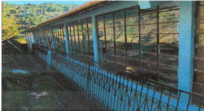
Foto 2: VENTANA, colocacion de balcones de metal
