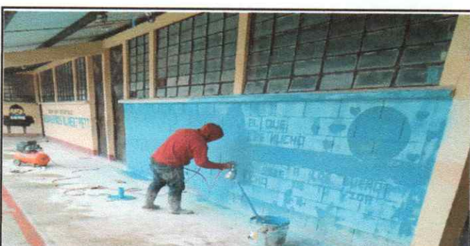
Foto 6: PINTURA EN MUROS EXTERIORES E INTERIORES
