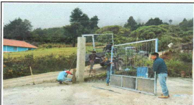
Foto 3: PUERTAS DE METAL, Sustitución de portón de metal
