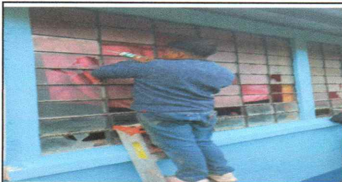
Foto1: VENTANAS, sustitucion de vidrios
