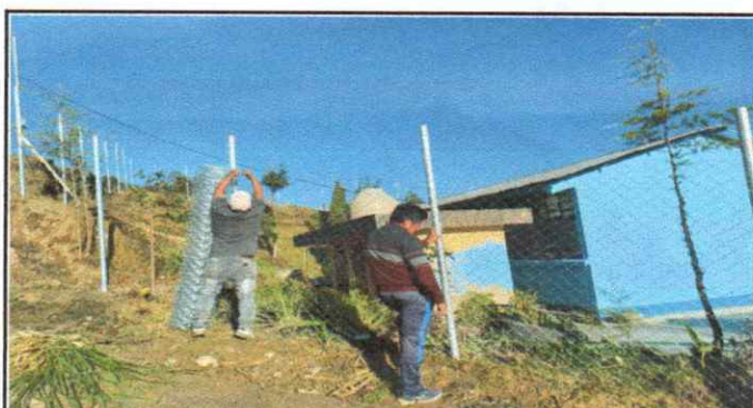
Foto 4: MUROS PERIMETRALES, Reparación de tubo hg y malla galvanizada
