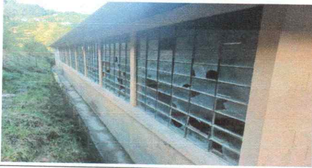
Foto 1: VENTANAS, sustitucion de vidrios
