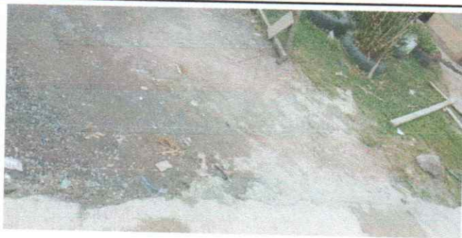
Foto 5: LOSA DE PATIO, colocacion de torta de cemento
