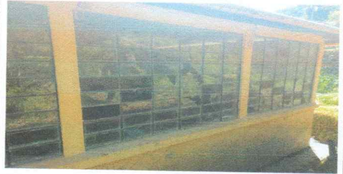
Foto 2: VENTANA, colocacion de balcones de metal
