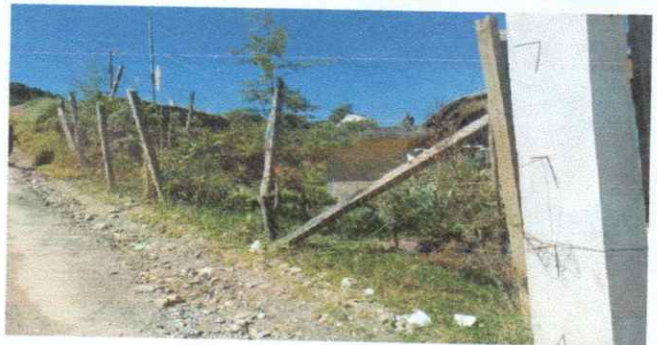
Foto 4: MUROS PERIMETRALES, Reparación de tubo hg y malla galvanizada
