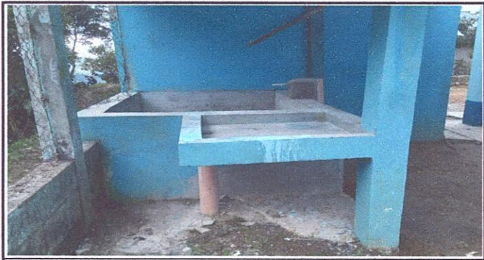
Foto 5: Sustitucion de llaves de chorros y tubería línea principal.
