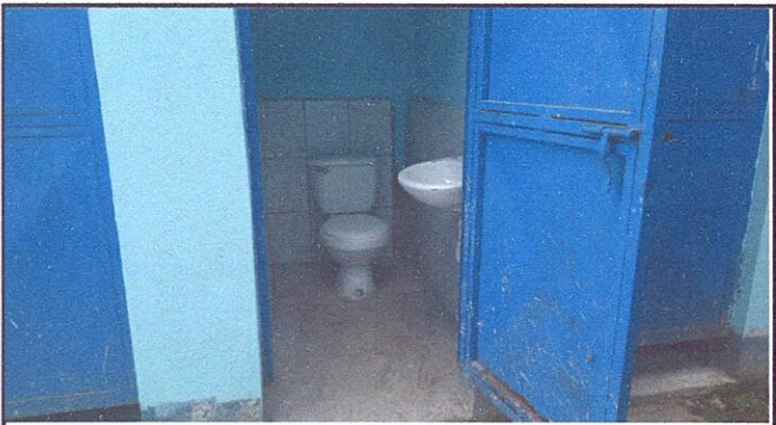
Foto 2: Sustitucion de accesorios de inodoros y lavamanos,
