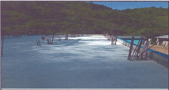
Foto 6: Impermeabilizacion de losa
