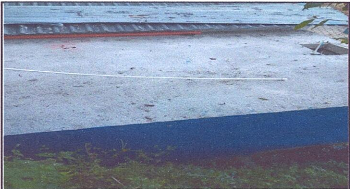
Foto 4: Sustitucion de tubería línea principal
