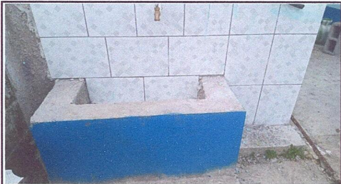
Foto 3: Mejoramiento de migitorio y Pintura de muros interiores y exteriores de los baños.
