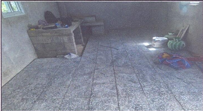
Foto1: Mejoramiento de mueble de concreto, piso de granito y pintura de paredes interiores de la cocina.
