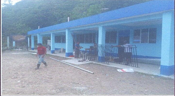
Foto 8: Mejoramiento de balcones de metal parte frontal de la escuela
