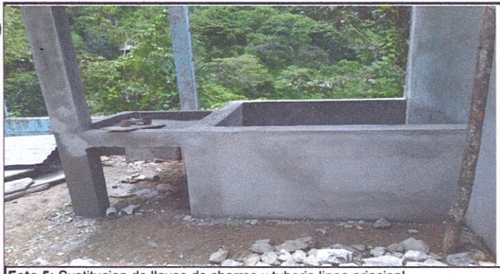
Foto 5: Sustitucion de llaves de chorros y tuberia linea principal.
