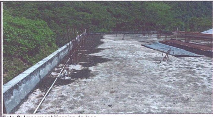
Foto 6: Impermeabilizacion de losa
