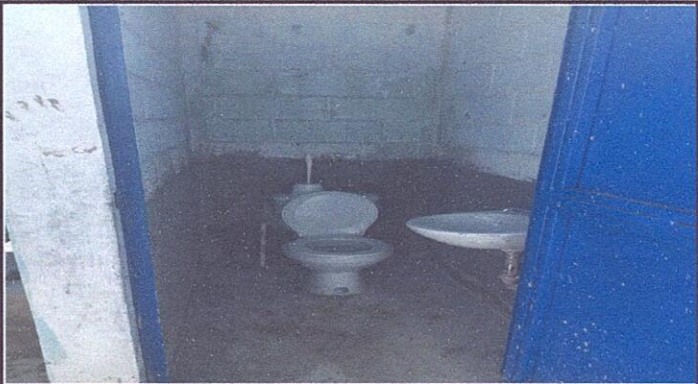
Foto 2: Sustitucion de accesorios de inodoros y lavamanos,
