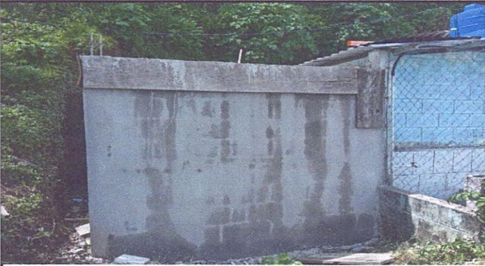
Foto 9: Repello y reparacion de sisterna de agua.
