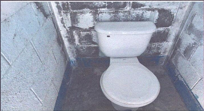
Foto 2: Sustitucion de accesorios de inodoros y lavamanos,
