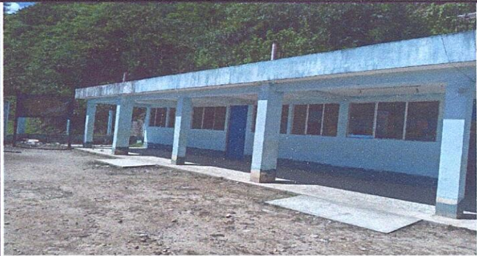
Foto 7: Pintura en muros interiores y exteriores de la escuela
