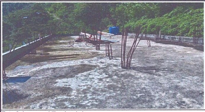
Foto 6: Impermeabilizacion de losa
