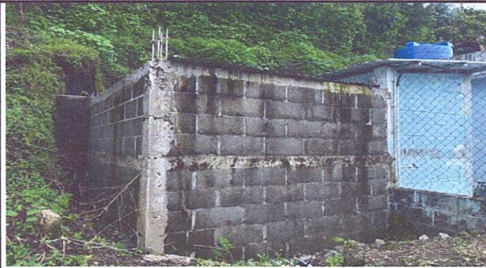
Foto 9: Repello y reparacion de sisterna de agua.
