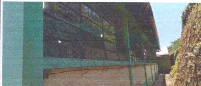
Foto 2: Sustrucción de balcones de metal
