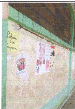
Foto 3: Aplicación de pintura para aulas EXTERIOR Y INTERIOR
