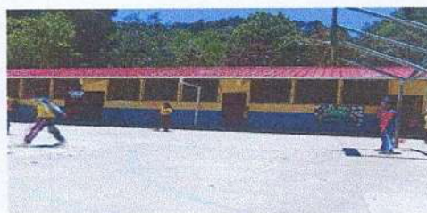
Foto 6: Pintura de aulas exteriores e interiores
