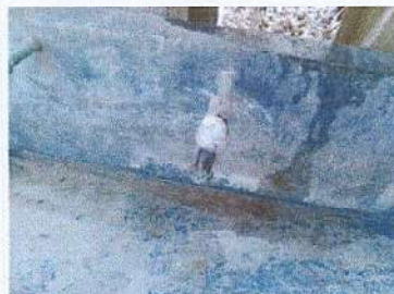
Foto 2: Sustrucción llave de chorro
