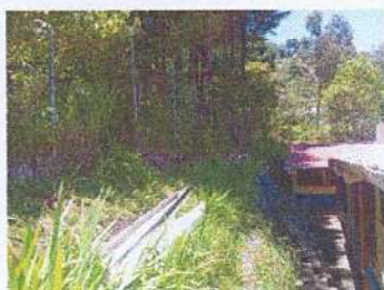
Foto 5: Sustrucción malla galvanizada
