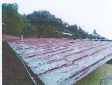
Foto 3: Sustrucción cubierta de lámina
