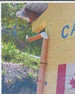
Foto1: Sustrucción de canales y bajadas de agua
