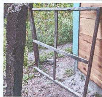
Foto 6: Mejoramiento de columnas del porton de ingreso
