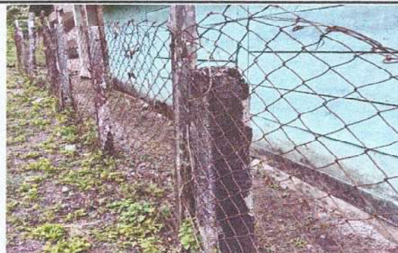
Foto 2: Sustitución tubo hg y malla galvanizado
