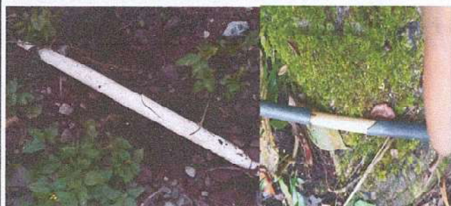
Foto 1 Sustitución de tubería línea principal
