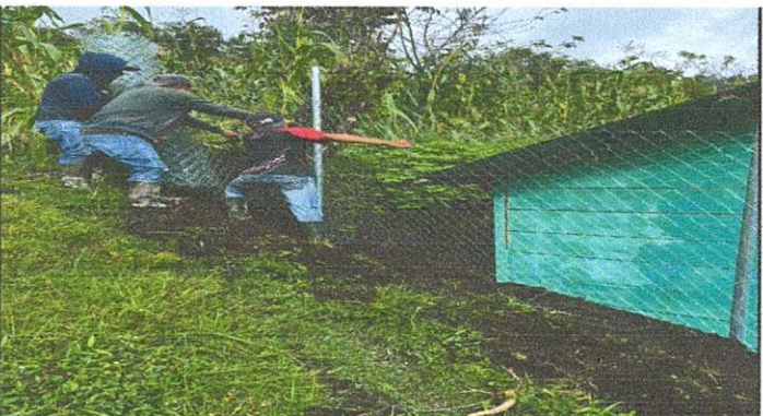
Foto 4: mejortamiento de muro perimetral. Colocación de tubos galvanizados y sustitución de mallas.
