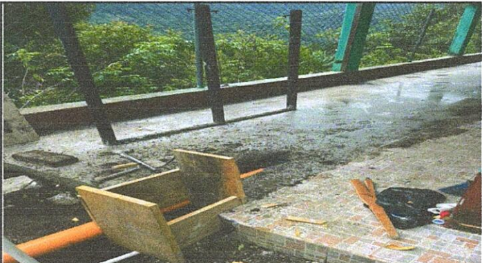
Foto 2: Mantenimiento de cuneta de cemento, sustitución de parrilla por torta de cemento
