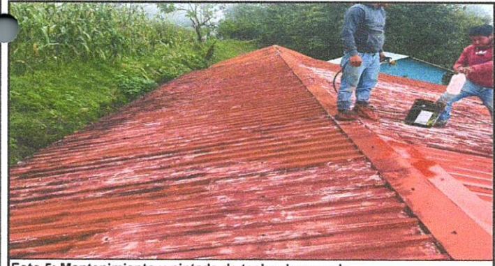
Foto 5: Mantenimiento y pintada de techo de escuela.
