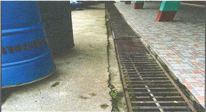
Foto 2: Mantenimineto de cuneta de cemento, sustitución de parrilla por torta de cemento
