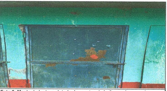
Foto 6: Mantenimiento y pintada de puertas de baños, aulas y cocina
