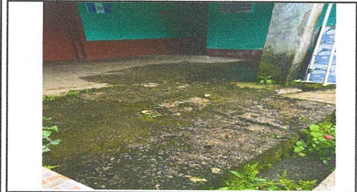
Foto 3: Mantenimiento de piso de cemento, sustitución por torta de cemento
