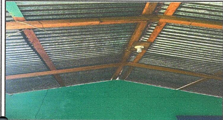
Foto1: Cambio de techo de cocina, de madera a metal y sustitución de láminas por láminas troqueladas
