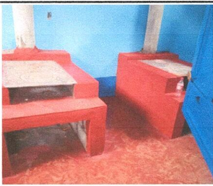
Foto 6: Sustitución de plancha de metal de 3 hornillas y estructura
