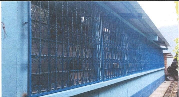
Foto 4: Sustitución de balcones de 1.73 x 1.75 metros
