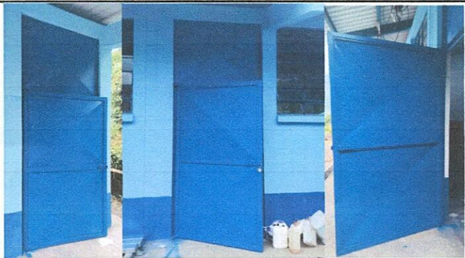
Foto 3: Mantenimiento a estructura
