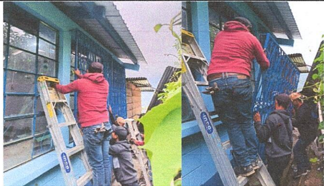
Foto 4: Sustitución de balcones de 1.73 x 1.75 metros
