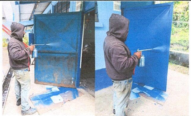
Foto 3: Mantenimiento a estructura
