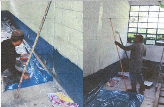
Foto 5: Pintura en muros exteriores e interiores
