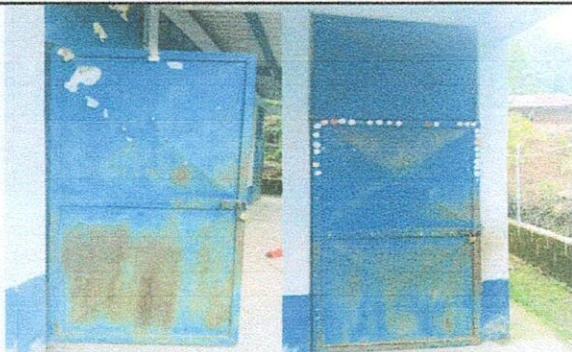
Foto 3: Mantenimiento a estructura
