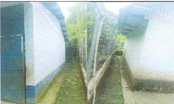
Foto 5: Pintura en muros exteriores e interiores
