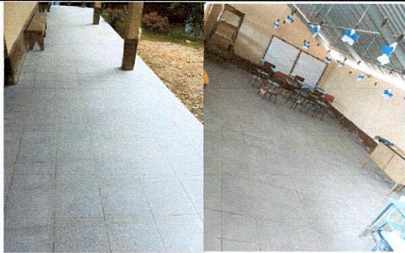
Foto 3.3: Sustitución de piso de cemento a piso de granito
