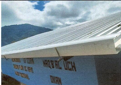
Foto 4: Sustitución de canales y bajadas de agua pluvial
