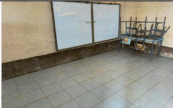
Foto 3.2: Sustitución de piso de cemento a piso de granito
