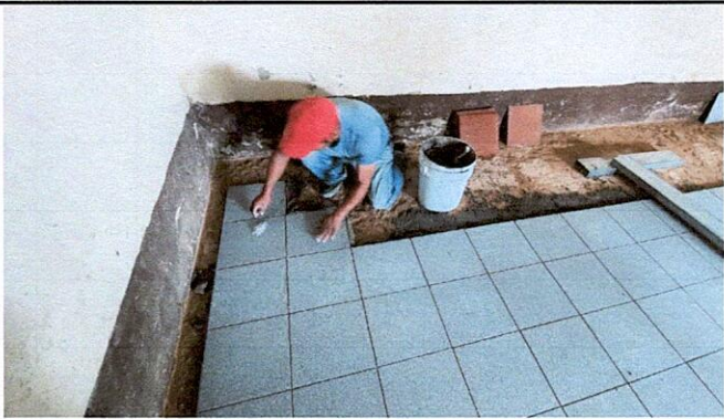
Foto 3.1: Sustitución de piso de cemento a piso de granito
