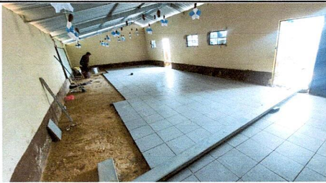
Foto 3.3: Sustitución de piso de cemento a piso de granito
