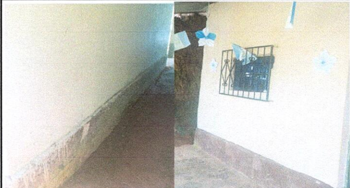
Foto 2: Pinturas en muros exteriores e interiores de aulas
