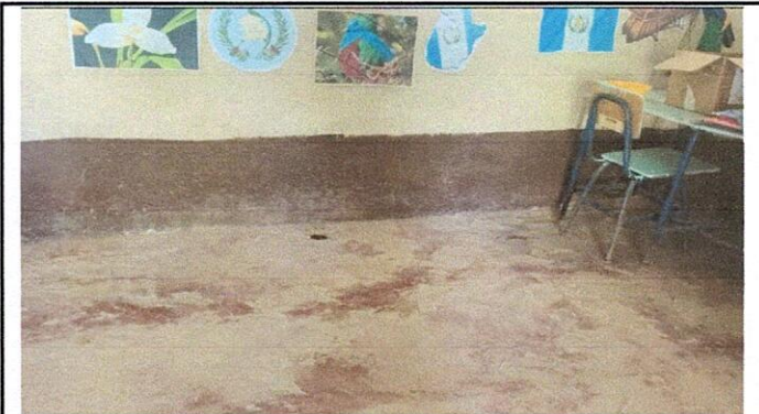
Foto 3.1: Sustitución de piso de cemento a piso de granito
