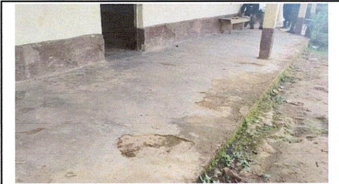
Foto 3.2: Sustitución de piso de cemento a piso de granito
