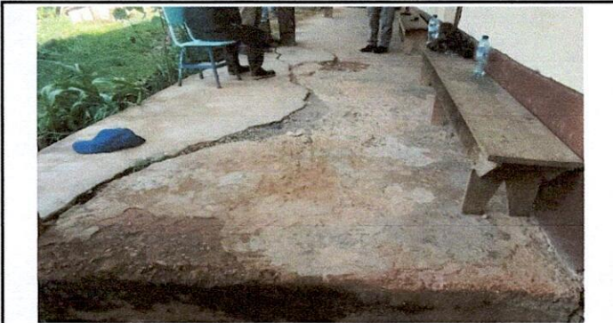
Foto 3.3: Sustitución de piso de cemento a piso de granito
