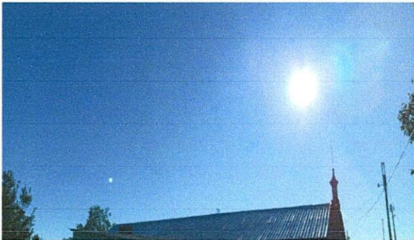
Foto2: Sustitucion de capote de lamina para lamina troquelada
