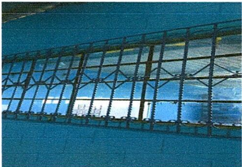
Foto 9: Mantenimiento a estructra de metal de ventana
