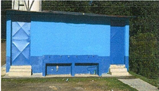
Foto 11: Mantenimiento de estructura (lijado y aplicación de pintura en puertas de metal de los servicios sanitarios
