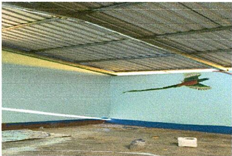
FOTO 3: Sustitución de estructura de soporte de madera por metal galvanizado
