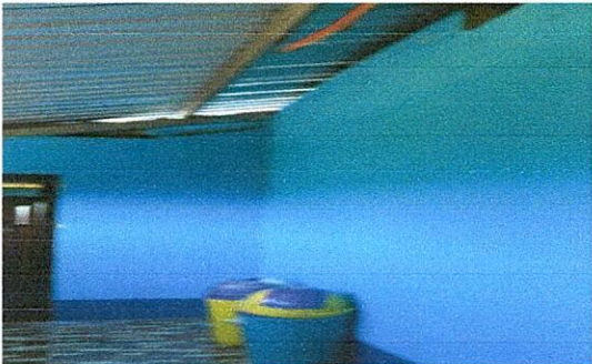
Foto 8: Pintura en muros exteriores e interiores
