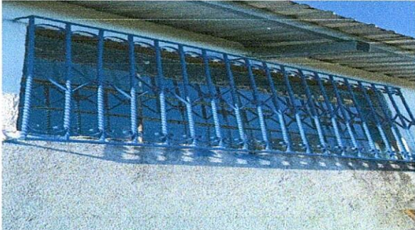
Foto 10: Mantenimiento a balcones de metal
