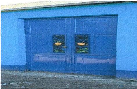
foto 12. Mantenimiento de estructura en puertas del centro educativo
