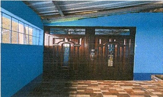
Foto 5: Sustitución de portón de metal.
