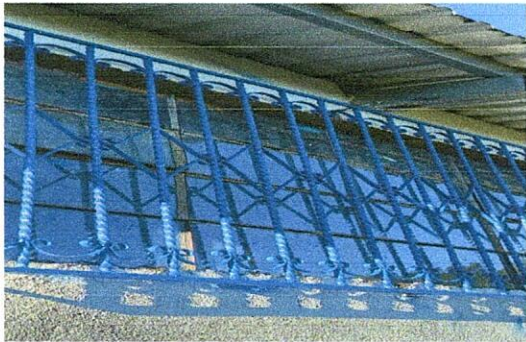
Foto 10: Mantenimiento a balcones de metal
