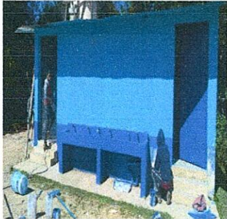
Foto 11: Mantenimiento de estructura (lijado y aplicación de pintura en puertas de metal de los servicios sanitarios
