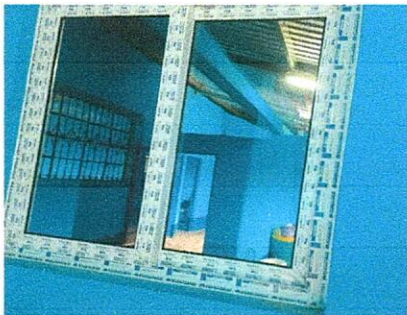
Foto 6: Sustitución de ventana de madera por metal mas vidrio transparente
