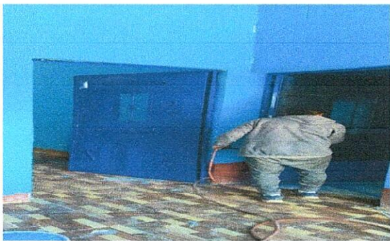
Foto 4: Mantenimiento de estructura (lijado y aplicación de pintura en puertas de metal, color negro anticorrosivo)
