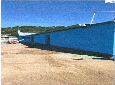
Foto 8: Pintura en muros exteriores e interiores
