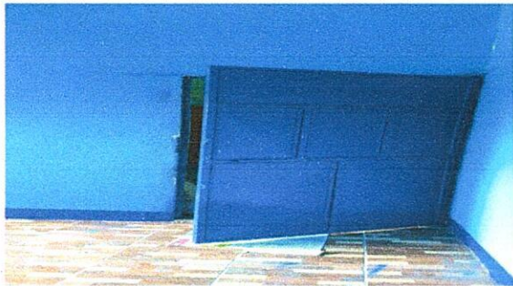
foto 12. Mantenimiento de estructura en puertas del centro educativo
