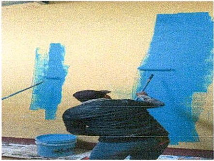
Foto 7: Pintura en muros exteriores e interiores
