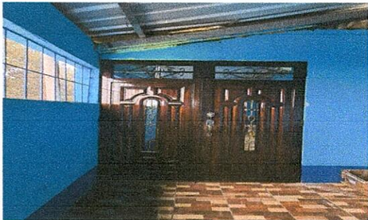
Foto 5: Sustitución de portón de metal.
