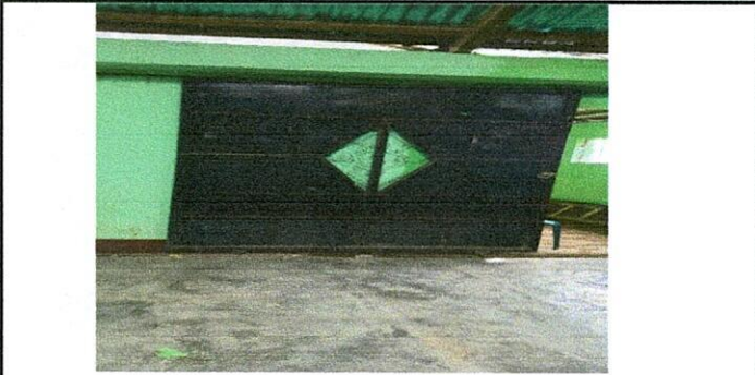
Foto 5: Sustitución de portón de metal.
