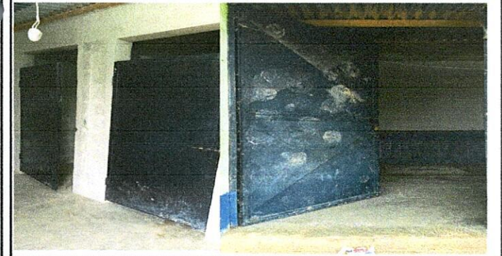
Foto 11: Mantenimiento de estructura (lijado y aplicación de pintura en puertas de metal de los servicios sanitarios
