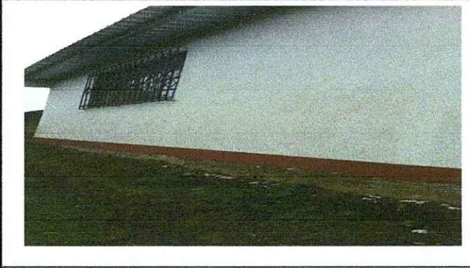
Foto 10: Mantenimiento a balcones de metal
