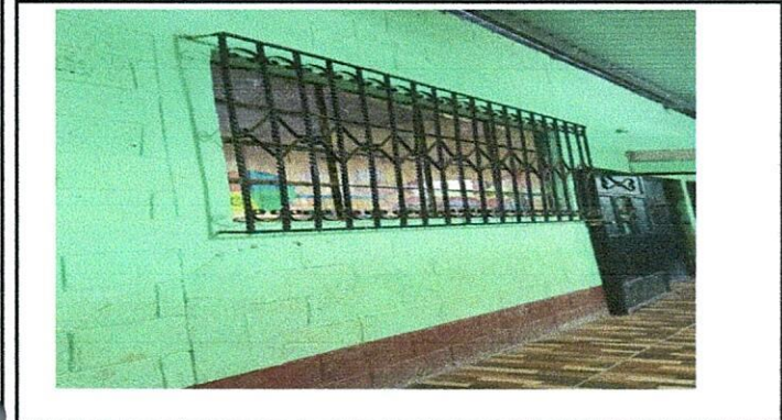
Foto 7: Pintura en muros exteriores e interiores
