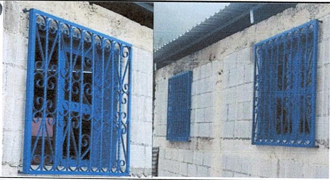
Foto 5: Sustitución de ventanas de 1 x 0.80 centímetros y Sustitución de balcones de 1 x 0.80 centímetros
