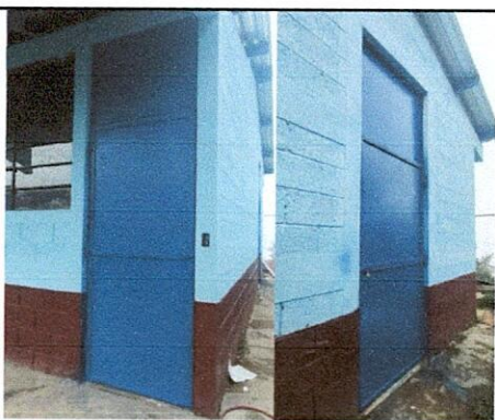
Foto 4: Sustitución de puertas de metal de 3.06 x 1 metros
