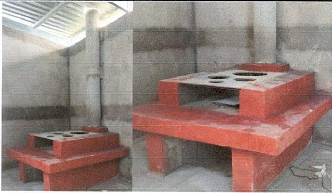
Foto 7. Sustitución de plancha de metal de 3 hornillas y estructura
