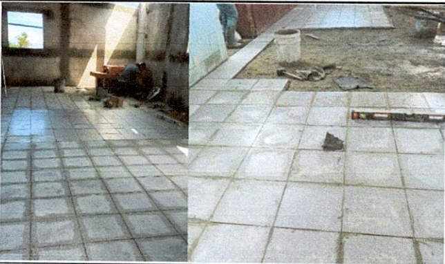
Foto 3: Sustitución de piso de granito
