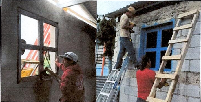
Foto 5: Sustitución de ventanas de 1 x 0.80 centímetros y Sustitución de balcones de 1 x 0.80 centímetros
