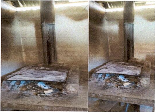
Foto 7. Sustitución de plancha de metal de 3 hornillas y estructura
