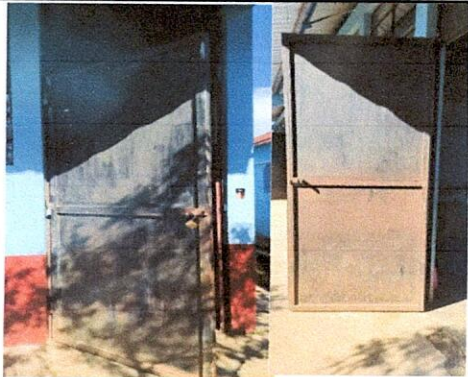
Foto 4: Sustitución de puertas de metal de 3.06 x 1 metros
