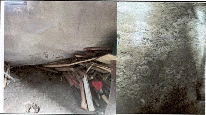
Foto 3: Sustitución de piso de granito
