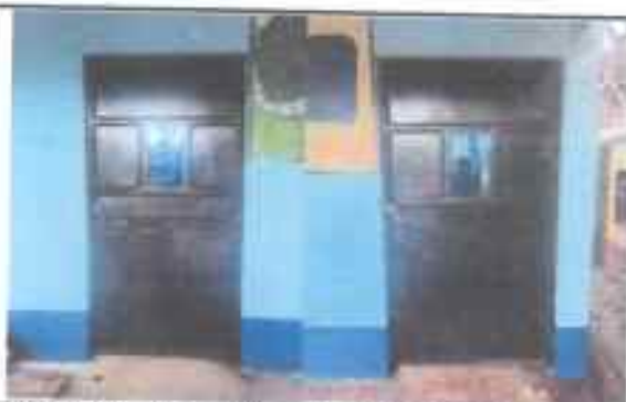
Foto 5: Mantenimiento a estructura de puertas de metal.
