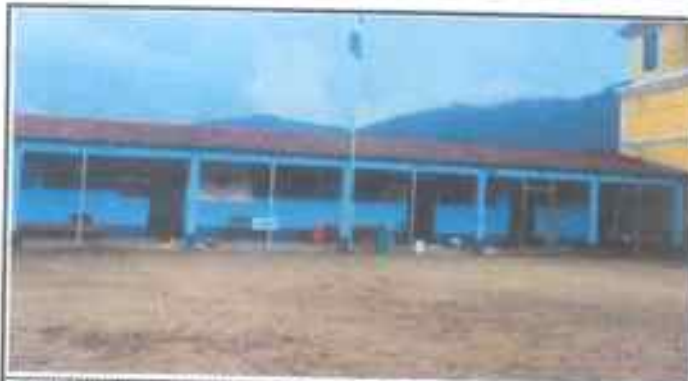
Foto 4: Pinturas en muros exteriores e interiores
