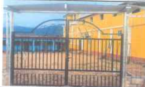
Foto 2: Sustitución de portón de metal, por portón de metal de 3.90m. X 1.75 m.
