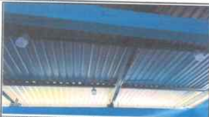
Foto 8: Reparación de sistema eléctrico
