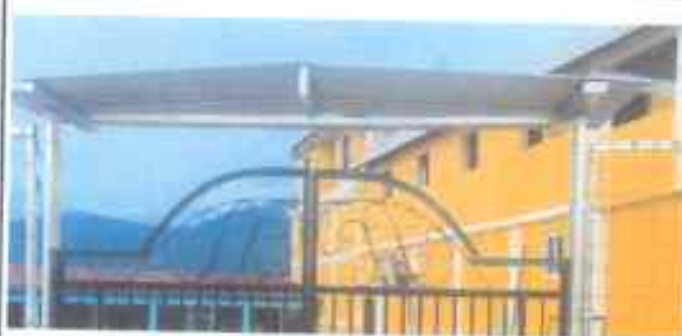
Foto 3: Sustitución de láminas, por láminas troqueladas aluzinc calibre 26
