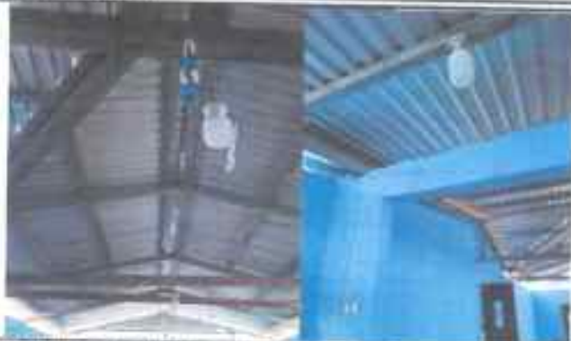
Foto 7: Reparación de sistema eléctrico.
