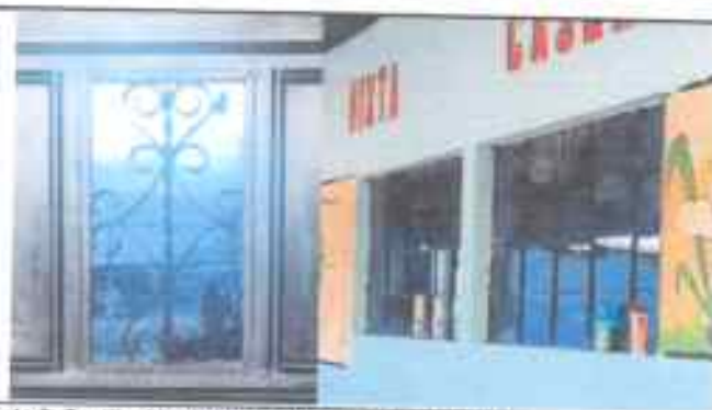
Foto 6: Sustitución de Vidrios de 48 X 26 centímetros
