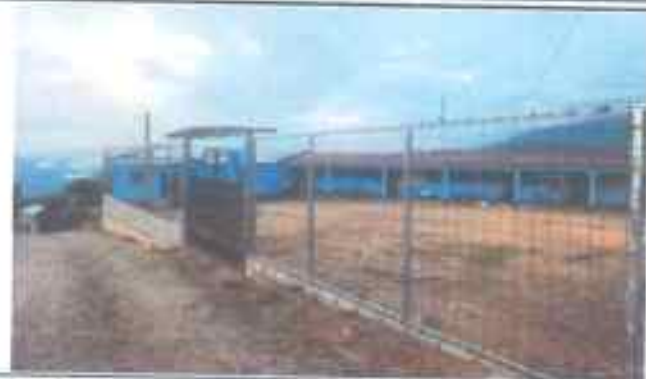
Foto 1: Sustitución de malta galvanizada y tubo HG.
