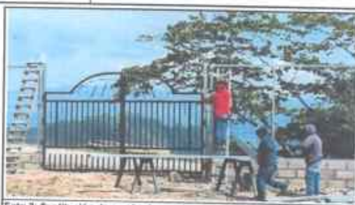
Foto 2: Sustitución de portón de metal, por portón de metal de 3.90m. X 1.75 m.
