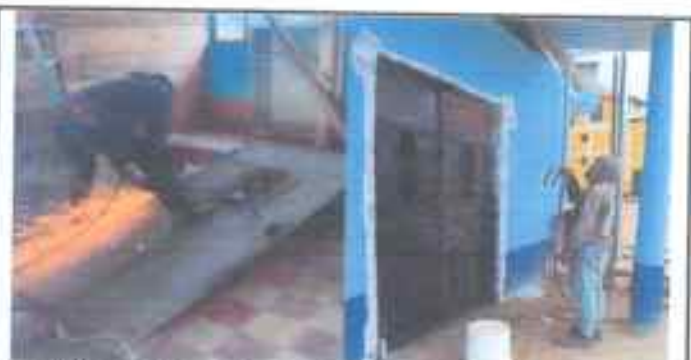
Foto 5: Mantenimiento a estructura de puertas de metal.
