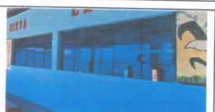
Foto 6: Sustitución de Vidrios de 46 X 26 centímetros
