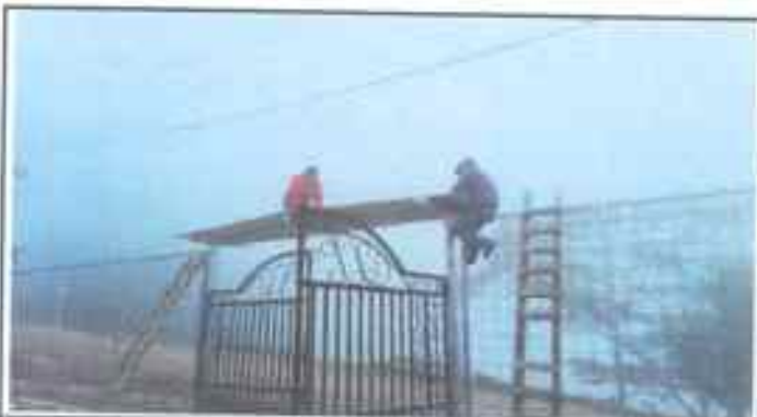
Foto 3: Sustitución de láminas, por láminas troqueladas aluzinc calibre 26
