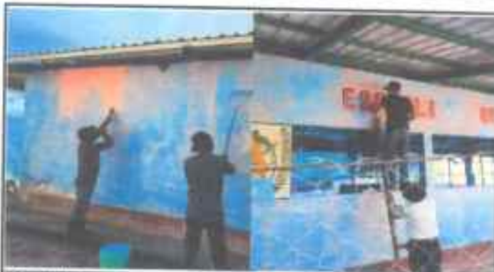
Foto 4: Pinturas en muros exteriores e interiores
