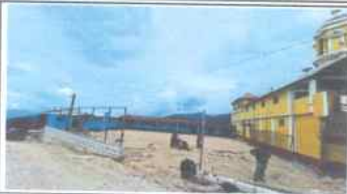
Foto 1: Sustitución de malla galvanizada y tubo HG.
