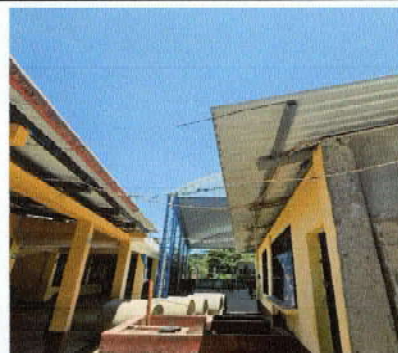
Foto 8: Sustrución de canal de metal
