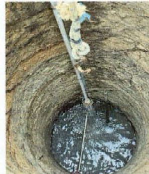
Foto 14: Sustitución de bomba de agua
