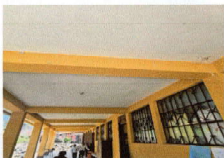
Foto 11: Sustrución de focos ahorradores
