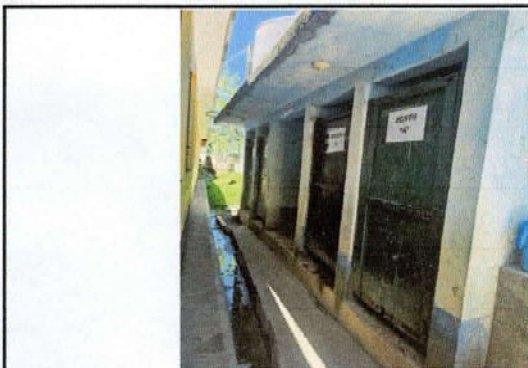
Foto 3: Sustitución de puerta de servicio sanitario (0.78 x 120 metros)
