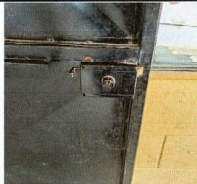
Foto 2: Sustitución de chapas
