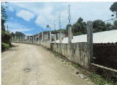
Foto9: Pintura en muros interiores y exteriores
