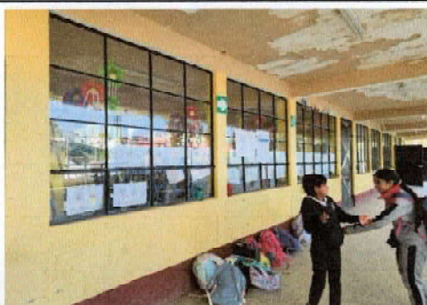
Foto 5: Mejoramiento de balcones de metal (2.45 x 1.6 por 3 ventanas)
