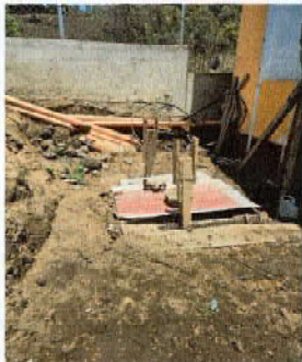
Foto 13: Reparación de cisterna de concreto (5 tubos de 36' para cisterna)
