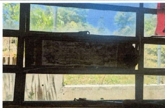
Foto 4: Sustitución de vidrios (50 x20 cm)
