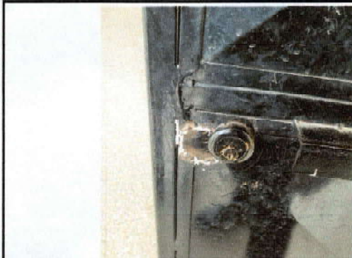
Foto1: Mantenimiento a estructura (cambio de bisagras y pintado 1.15 x 2.5 metros)
