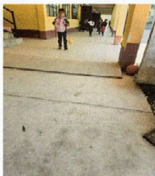
Foto7: Sustrución de piso de granito
