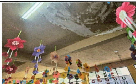
Foto 12: Sustrución de plafoneras
