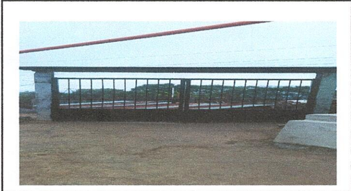
Foto 3: EN MODULO No. 4 PUERTA NUEVA
