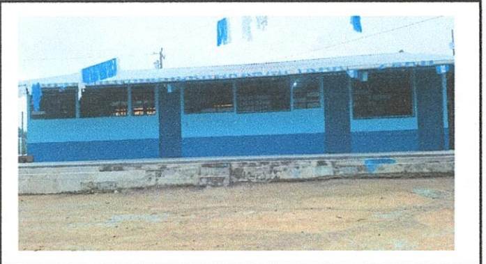
Foto 2: EN MODULO No. 9 PINTURA; PINTURA NUEVA
