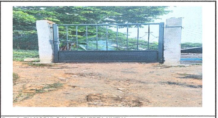
Foto 6: EN MODULO No. 4 PUERTA NUEVA
