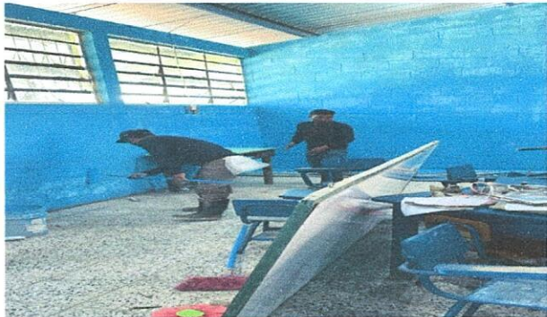
Foto 2: EN MODULO No. 9 PINTURA; SUSTITUCION DE PINTURA
