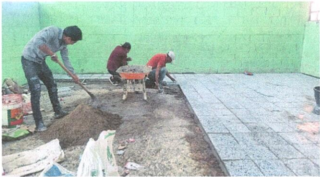
Foto1: EN MODULO No. 6 PISO; SUSTITUCION DE PISO
