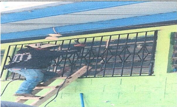
Foto 5: EN MODULO NO. 9 BALCÓN : INSTALACIÓN DE BALCÓN
