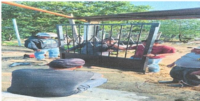
Foto 6: EN MODULO No. 4 PUERTAS SUSTITUCIÓN DE PUERTAS (VARIAS MEDIDAS)
