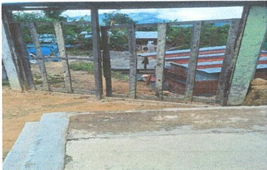
Foto 6: EN MODULO No. 4 PUERTAS SUSTITUCIÓN DE PUERTAS (VARIAS MEDIDAS)
