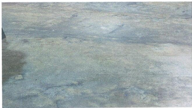
Foto 4:EN MODULO NO. 6 PISO. SUSTITUCIÓN DE PISO
