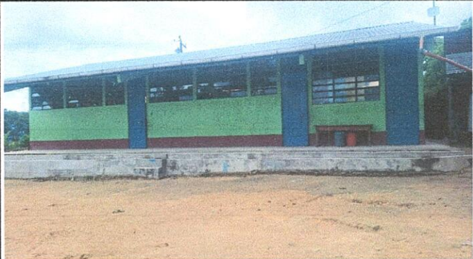
Foto 2: EN MODULO No. 9 PINTURA; SUSTITUCION DE PINTURA
