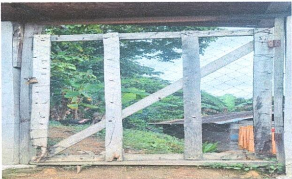
Foto 3: EN MODULO No. 4 PUERTAS SUSTITUCION DE PUERTAS. (VARIA MEDIDAS)
