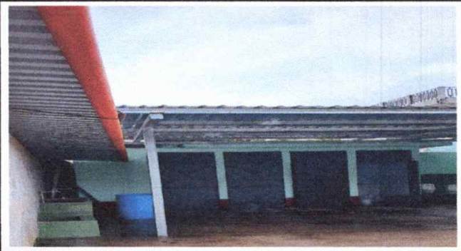
Foto 2: Sustitución de estructura del techo del baño
