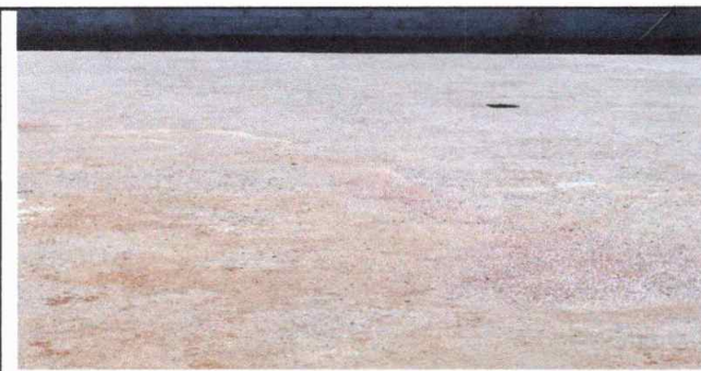
Foto 5: Sustitución de piso de concreto de 77 M2
