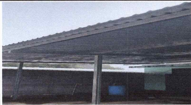
Foto 1: Sustitución de lamina troquelada
