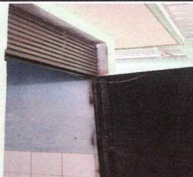
Foto 8: Mantenimiento de estructura, cambio de tubo y aplicación de pintura
