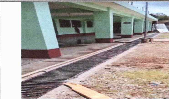
Foto 3: Reparación de cuneta y las rejillas 30 M
