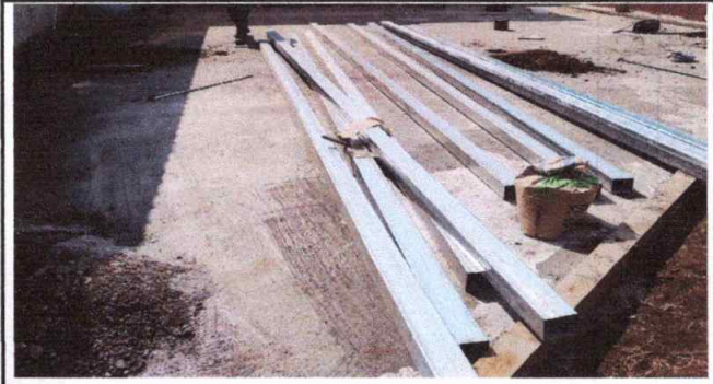
Foto 2: Sustitución de estructura del techo del baño
