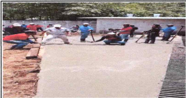
Foto 5: Sustitución de piso de concreto de 77 M2
