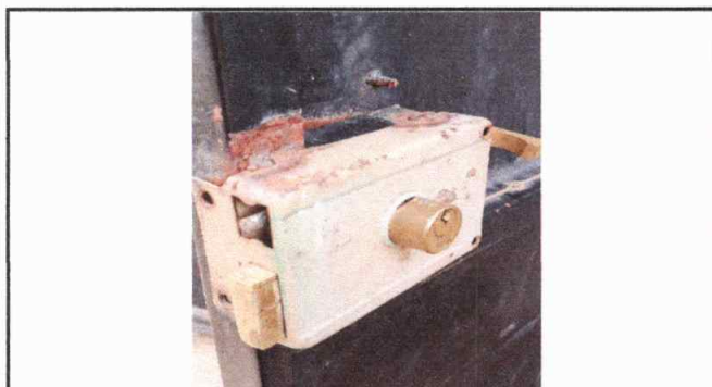
Foto 9: Sustitución de chapas
