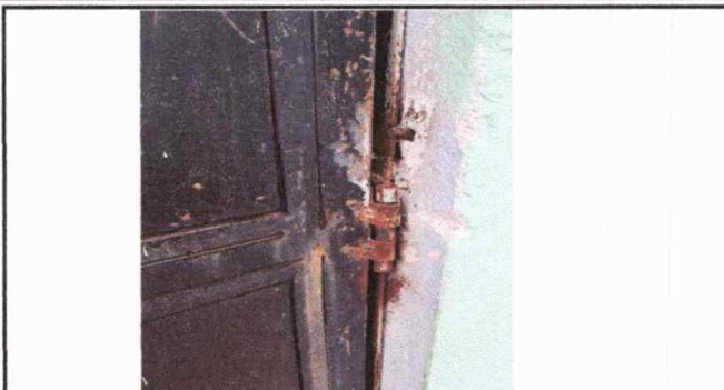
Foto 8: Mantenimiento de estructura, cambio de tubo y aplicación de pintura
