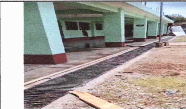
Foto 3: Reparación de cuneta y las rejillas 30 M
