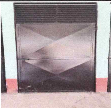
Foto 7: Mantenimiento de estructura, lijado y aplicación de pintura
