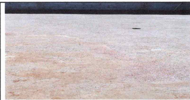
Foto 5: Sustitución de piso de concreto de 77 M2
