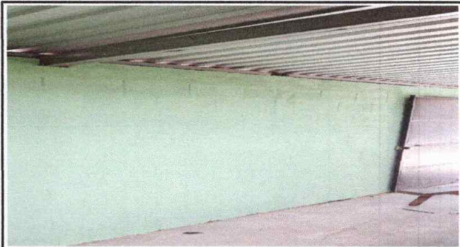
Foto 4: Pintura interior y exterior de la EORM 300 M2
