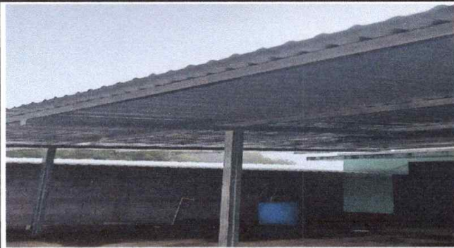
Foto 1: Sustitución de lamina troquelada
