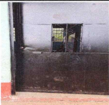
Foto 9: Sustitución de chapas
