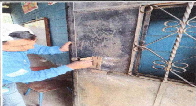
Foto 7: Mantenimiento de estructura, lijado y aplicación de pintura
