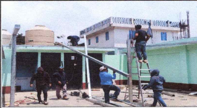
Foto1: Sustitución de lamina troquelada
