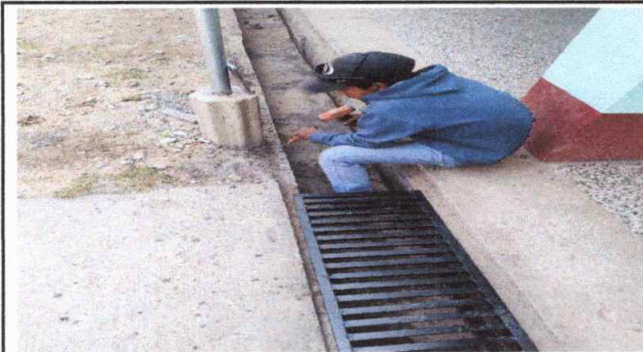
Foto 3: Reparación de cuneta y las rejillas 30 M
