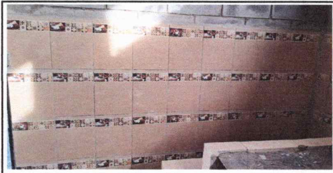
Foto 6: Instalación de azulejo en la cocina 10 M2
