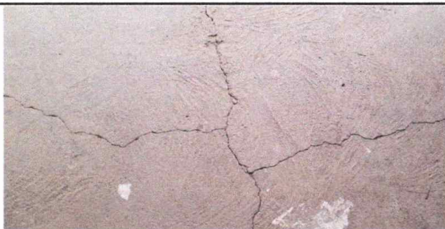
Foto 5: Sustitución de piso de concreto de 77 M2
