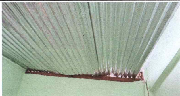
Foto1: Sustitución de lamina troquelada
