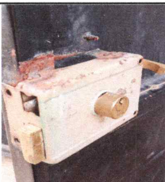
Foto 9: Sustitución de chapas
