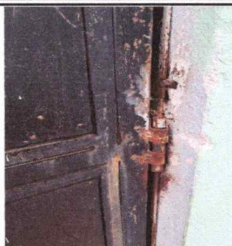
Foto 8: Mantenimiento de estructura, cambio de tubo y aplicación de pintura
