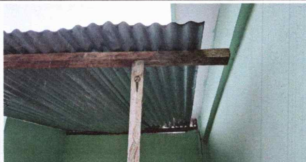
Foto 2: Sustitución de estructura del techo del baño
