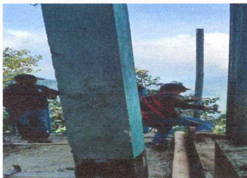
Mejoramiento del muro
