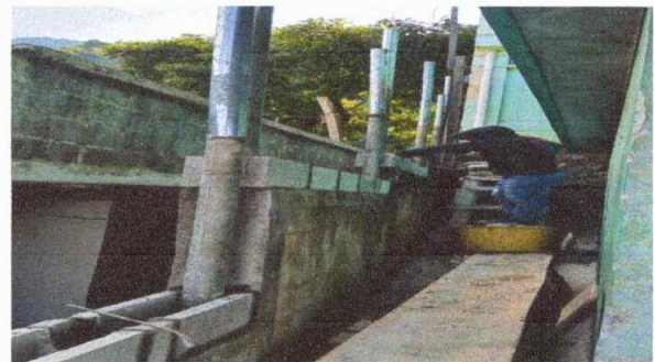
Cambio de tubos galvanizados
