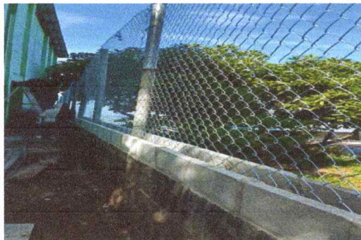
Durante: colocación de Maya galvanizada en muro
