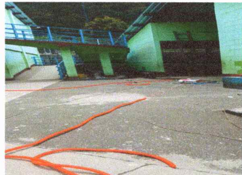
Durante : Cambio de cableado de energía eléctrica
