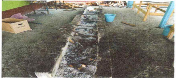
Antes: renglón Reparación de cocina, se realizará un mantenimiento a la estufa rural
