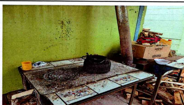
Foto 4: se sustituirá por otra nueva
