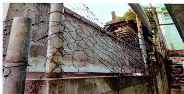
Foto 6: Se sustituirá la malla y tubos debido a que la estructura está en mal estado.
