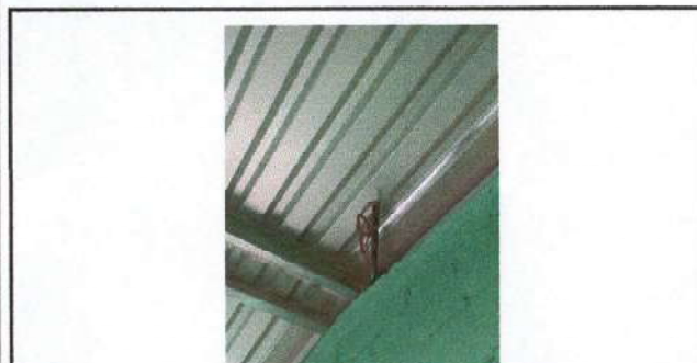
FOTO. 5 REPARACIÓN DE SISTEMA ELÉCTRICO
