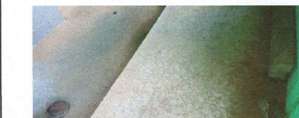
FOTO. 4. REPARACIÓN DE COCINA
