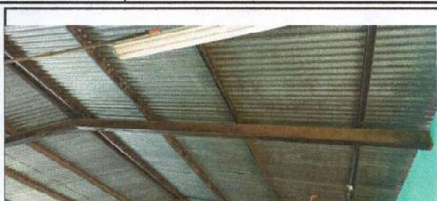
FOTO. 7 CUBIERTA DE LAMINA
