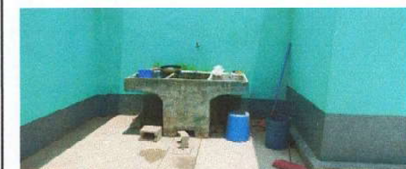
FOTO. 6 REPARACIÓN Y MANTENIMIENTO DE CISTERNAS / DEPÓSITOS DE AGUA
