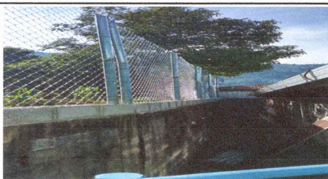
Despues: Reparacion de la malla con tubo galvanizado
