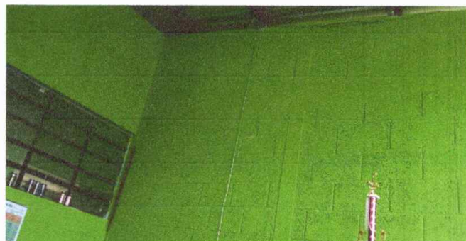
Pintura en paredes
