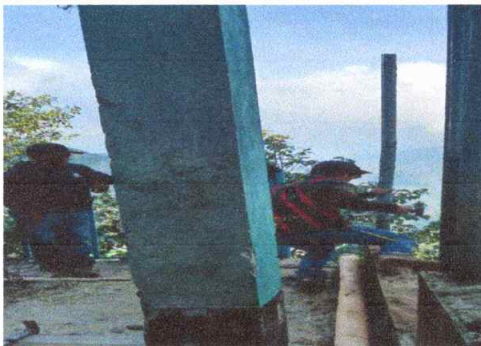
Mejoramiento del muro
