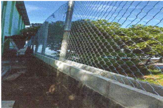
Durante: colocación de Maya galvanizada en muro
