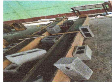
Durante: Mejoramiento de cocina y cambio de plancha
