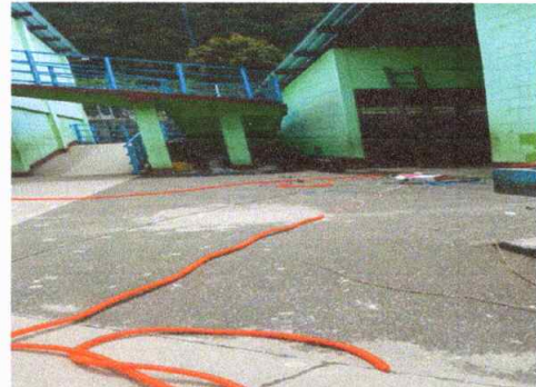
Durante : Cambio de cableado de energía eléctrica
