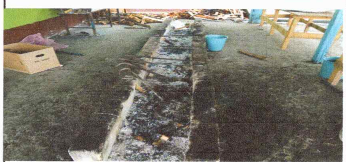
Antes: renglón Reparación de cocina, se realizará un mantenimiento a la estufa rural
