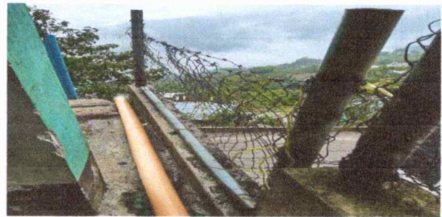
Antes: Muro perimetral se reforzará para ensamblar la malla
