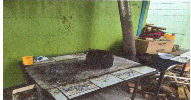
Antes: sustitución de estufa rural completa incluyendo chimenea y plancha de metal de tres ornillas
