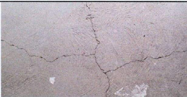
Foto 5: Sustitución de piso de concreto de 77 M2
