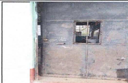
Foto 7: Mantenimiento de estructura, lijado y aplicación de pintura
