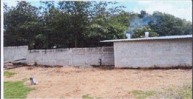
Foto 4: Pintura interior y exterior de la EORM 300 M2
