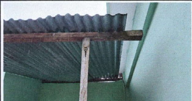
Foto 2: Sustitución de estructura del techo del baño
