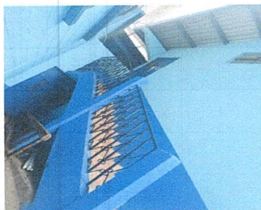
Foto 6: MANTENIMIENTO DE BARANDAS DE METAL
