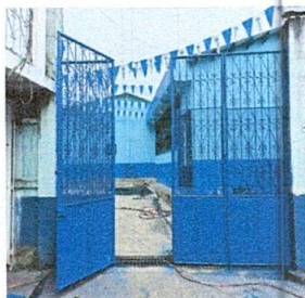
Foto 3: Sustitución de puerta de metal de 0.80 centímetros de ancho por 2.10 metros de alto
