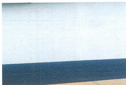
Foto 5: PINTURA DE MUROS EXTERIORES E INTERIORES
