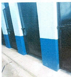
Foto 3: Sustitución de puerta de metal de 0.80 centímetros de ancho por 2.10 metros de alto
