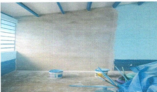
Foto 5: Mejoramiento de paredes y sernido de muros
