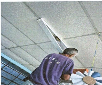
Foto 3: Sustrucion de focos tipo led
