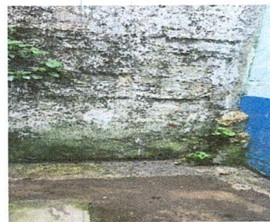
Foto 4: Sustrucion de pila de cemento de 2 lavaderos
