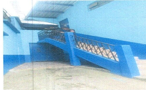
Foto 6: MANTENIMIENTO DE BARANDAS DE METAL
