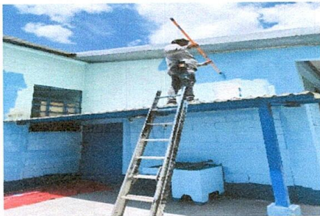
Foto 5: PINTURA DE MUROS EXTERIORES E INTERIORES
