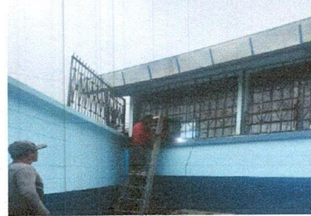
Foto 4: MANTENIMIENTO DE ESTRUCTURA DE VENTANAS DE METAL
