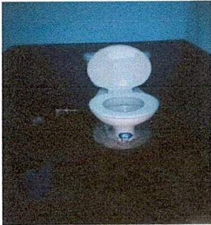
Foto 1: Sustrucion de inodoro y sus accesorios
