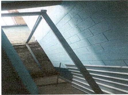
Foto 1: Mejoramiento de lámina por lámina troquelada aluzinc calibre 26
