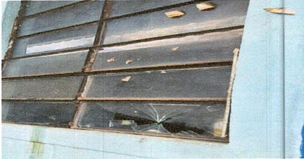
Foto1: Sustitución de vidrios de 24 centímetros de alto por 45 centímetros de ancho
