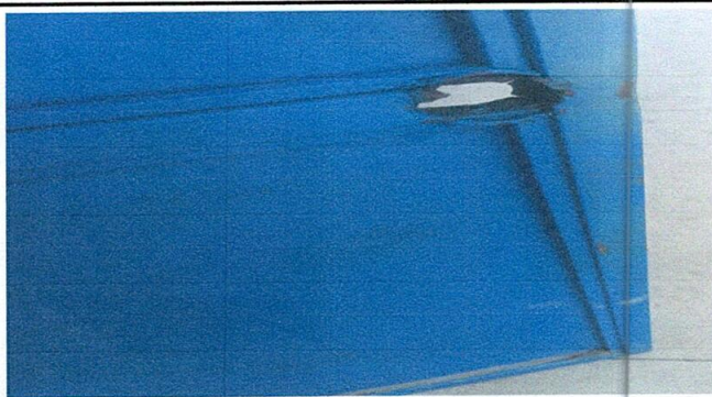
Foto 5: Sustitución de chapa
