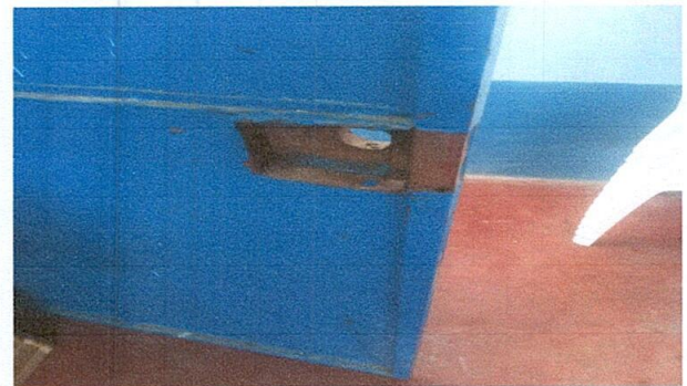
Foto 4: Mantenimiento de estructura de metal de puerta consistente en lijado, cepillado y pintura
