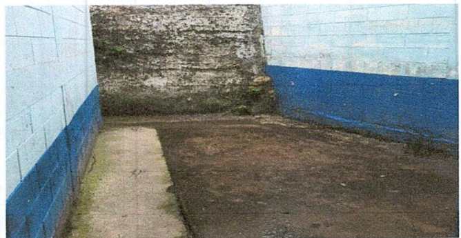
Foto 4: Reparación de planchas de concreto de patio
