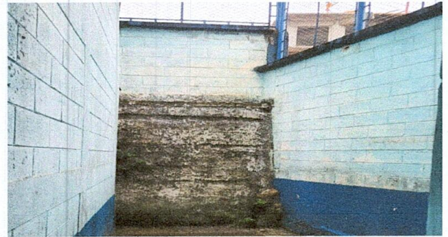
Foto 2: Mejoramiento de estructura de soporte de metal
