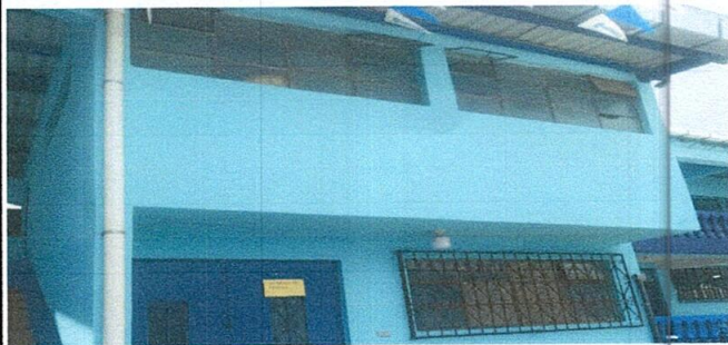
Foto 5: Sustitución de canal de metal y Sustitución bajada de agua pluvial tubo PVC 3"
