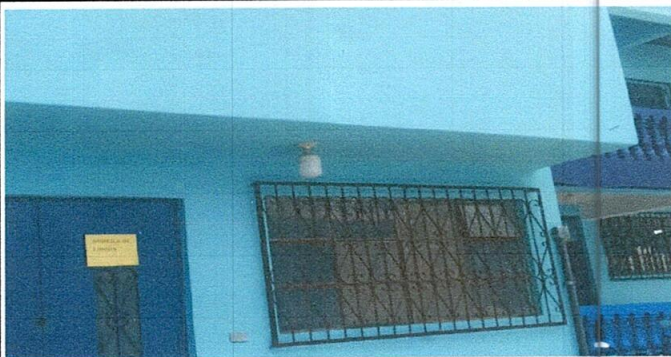
Foto 3: Mantenimiento de balcones de metal
