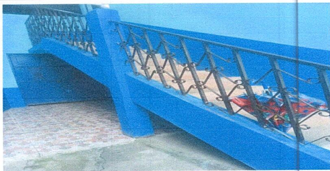
Foto 3: Mantenimiento de barandas de metal
