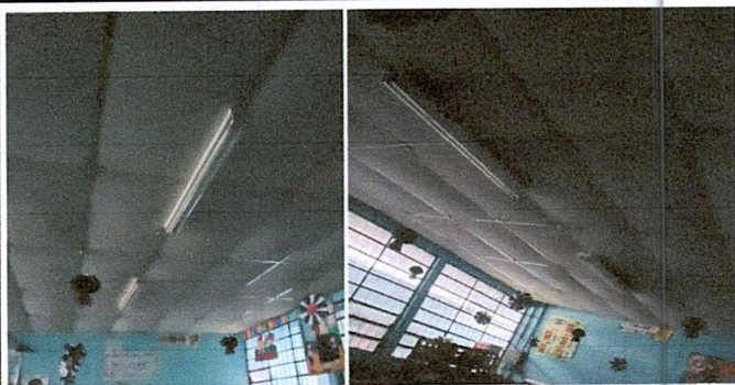
Foto 5: Sustitución de focos tipo LED
