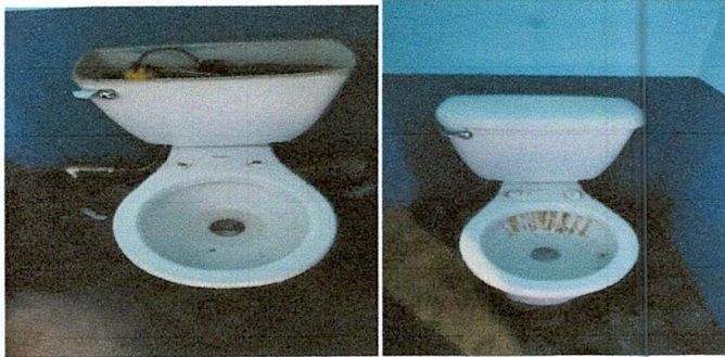
Foto1: Sustitución de inodoros y sus accesorios
