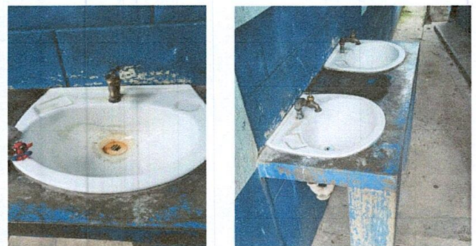
Foto 2: Sustitución de lavamanos
