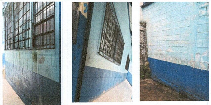
Foto 6: Pintura de muros exteriores e interiores
