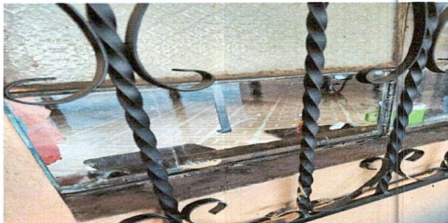
Foto1: Sustitucion de vidrios de 42 centímetros de ancho por 41 centímetros de alto
