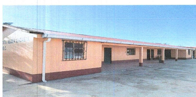
Foto 4: Mejoramiento de canal de metal
