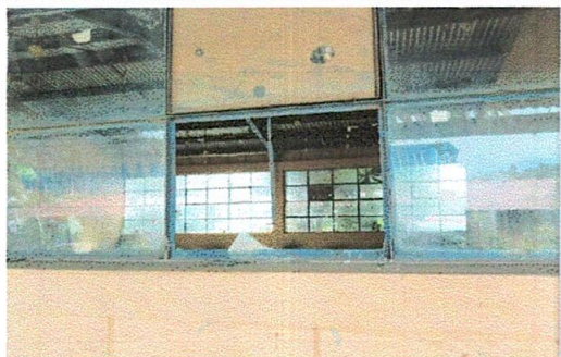
Foto 1: Sustitución de vidrios de 42 centímetros de ancho por 41 centímetros de ancho
