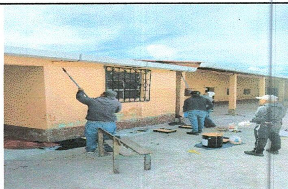
Foto 3: Pintura en muros exteriores e interiores
