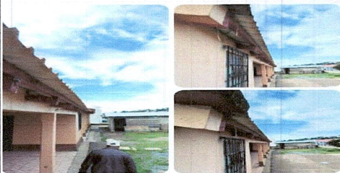
Foto 3: Mejoramiento de bajada de agua pluvial, tubo PVC 3"
