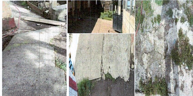
Foto 2: Sustitución de planchas de concreto de patio
