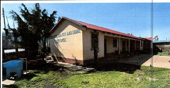
Foto 3: Pintura en muros exteriores e interiores
