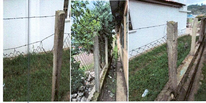
Foto 4: Reparación de tubo hg y malla galvanizada
