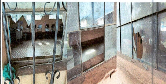
Foto 1: Sustitución de vidrios de 42 centímetros de ancho por 41 centímetros de ancho
